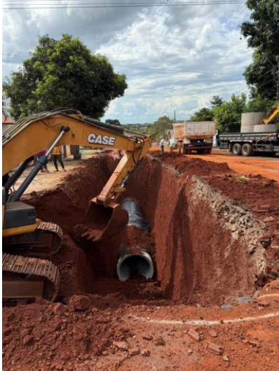
Figuras 2 a 9 – Execução da obra de Macro drenagem
